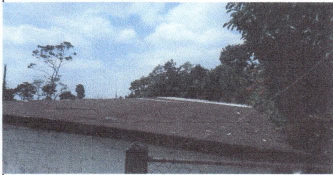
Foto 1. se cambiará el techo por lámina acanalada y se ampliará la pared
