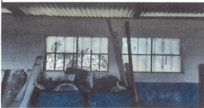
Foto 3: Sustitución de estructura de metal de ventana
